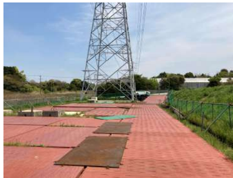
送電線工事現場の鋼製マット敷設
