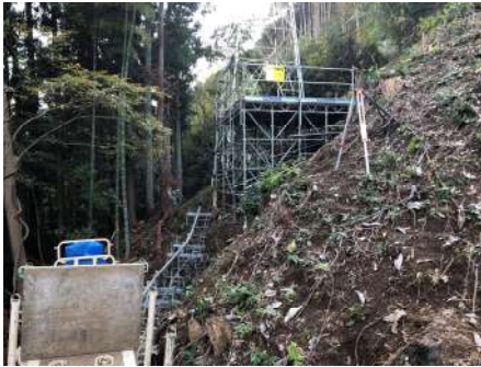
送電線工事現場のエプロンステージとモノレール
