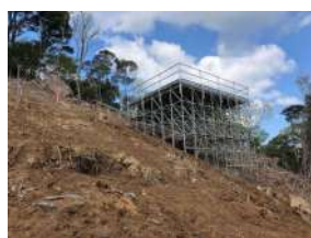
送電線工事現場のエプロンステージ
